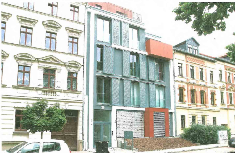
Moderne Lückenbebauung: Im Markkranstädter Parkstraßen-Carree hat sich in den vergangenen Jahren einiges getan. Jüngstes Beispiel ist das neue Mehrfamilienhaus Nummer 6, das den 15 Mietparteien dank Erdwärmeheizung umweltbewusstes Wohnen mit günstigen Betriebskosten garantiert. Foto: André Kemper
