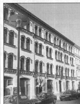
Tolle Fassade frisch saniert: Schramms Hof in der Münzgasse. Fotos: U. Pulwitt
