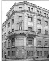
Der Zustand vor der Sanierung: Turm, Dachgeschoss und viele Details fehlen im Vergleich zum Original.
