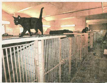
Baufällig: Im derzeitigen Katzendomizil in der Max-Liebermann-Straße 89 hygienischen Bedingungen nicht mehr den Vorschriften.
