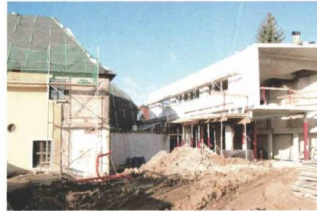
Die Vinothek im Bau
