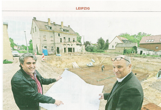
Ortstermin an der Baugrube: Bauleiter Mario Rui Alves Martins (links) und Architekt Anuschah Behzadi.
