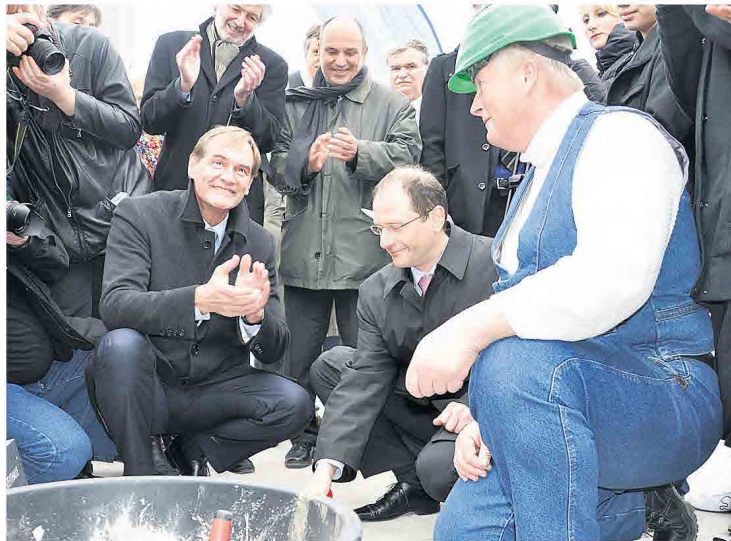
Zeitgeschichtliche Dokumente eingemauert: OBM Burkhard Jung, Staatsminister Markus Ulbig und Polier Frank Deutsch (v. l.) brachten die traditionelle Kassette im Grundstein unter. Foto: abl
