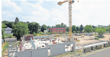
Die neue Gerätehalle in Potsdam. Luftschiffhafen soll ab 2019 die alte Turnhalle ersetzen.
