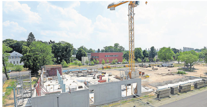
Die neue Geräteurnhalle im Potsdamer Luftschiffhafen soll ab 2019 die alte Turnhalle ersetzen.
